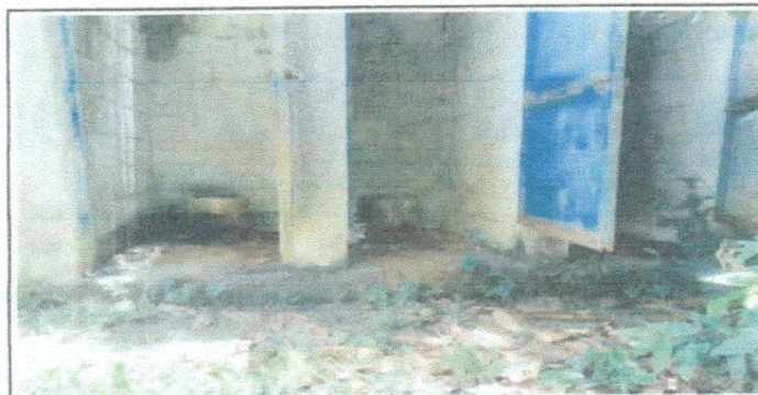
Foto 5: Se observa en la fotografía el deterioro de la pared, puertas y taza del baño.
